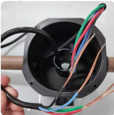
**4°** Decape o cabo de alimentação com aproximadamente 2 centímetros, para realizar uma emenda de derivação.
